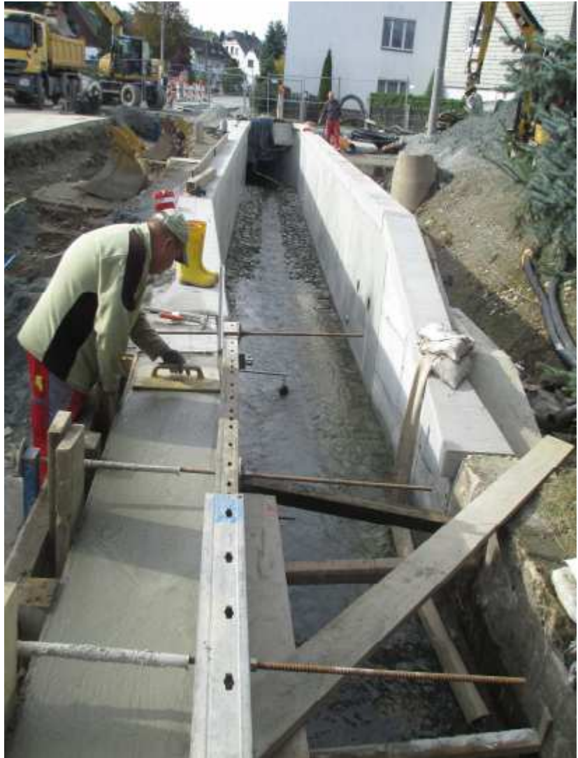
Das neue Bachbett des Dorfbachs mit Betonbauteilen.
