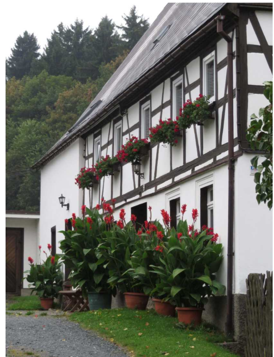
Liebevoll erhaltenes und gepflegtes ehem. Wohnstallhaus eines Zweiseithofes, Fritz-Reuter-Straße 9, erbaut im 18. Jahrhundert.
